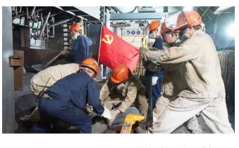
两两的工人,手持扳手和电筒,眉头紧锁,左 瞧瞧,右望望。没错,他们正在"找茬",找隐 患的茬。检查新安装好的水套是否有漏水, 这是保证投产后不出现安全隐患的重要-环。此刻需要工人们的火眼金睛,更需要他 们严谨的工作态度,一丝不苟的工作作风 千里之堤,毁于蚁穴。不马虎,不应付是每个 人对自己的基本要求。"这里有漏水,快来紧 一紧"、"这里阀门没拧好,加固一下",仿佛就 像工兵扫除了地雷一般,语气带着些兴奋,更 带着些许骄傲。是的,任何一处漏水点都可 能会在后面影响整个炉子的正常生产甚至被 迫停炉。这是责任心的体现,是我们工作认 真严谨的细致体现。
