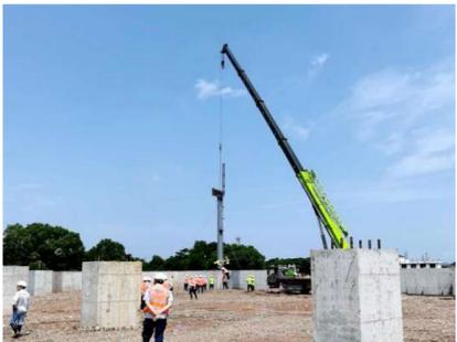
6月7日10点18分,在现场的礼炮声中,和丰多金属固废资源综合利用项目选矿渣棚第一根重达2.89吨钢柱顺利起吊,项目钢结构施工正式拉开序幕。项目部将在确保项目安全的基础上,以“一天也不耽误、一天也不懈怠”的工作态度,确保各项工期节点按时完成。(和丰环保 阎叶美)
