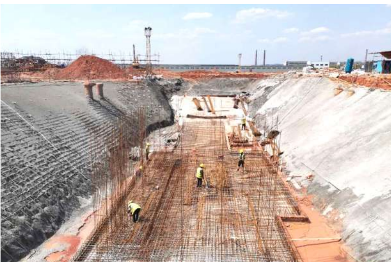
选矿车间粗碎厂房基础建设施工现场
